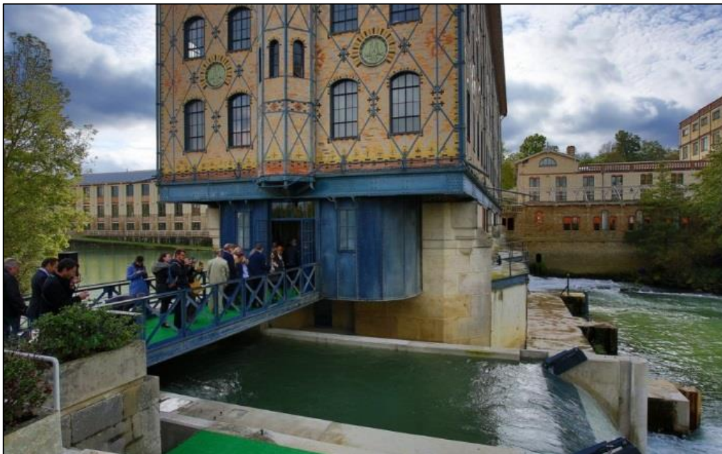
Turbine immergée au pied du Monument Historique de Noisiel
